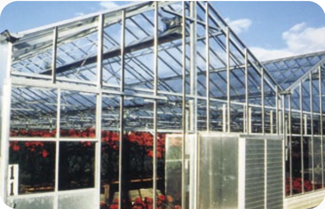
Sera Uygulaması: Seri Yakıclı Sistem - Genel Isıtma
