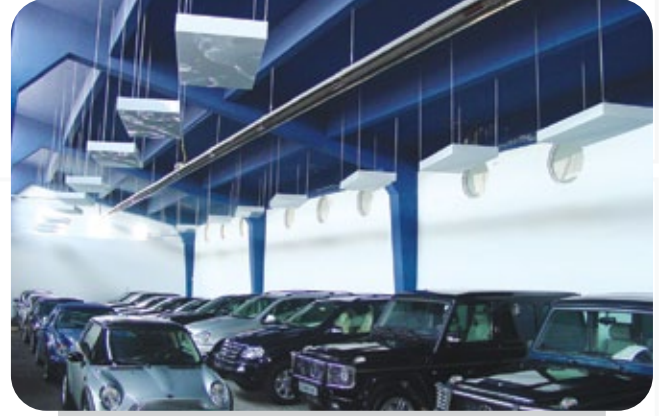
Showroom Uygulaması: Seri Yakıclı Sistem - Genel Isıtma
