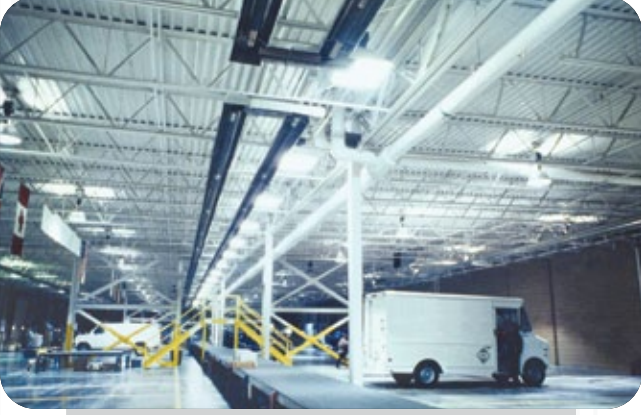
Depo Uygulaması: Seri Yakıclı Sistem - Genel Isıtma
