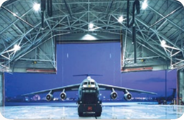
Hangar Uygulaması: Düz Tip Çok Yakıclı Sistem – Genel Isıtma
